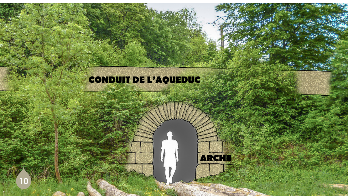
Fig. 5 : Reconstitution de l'arche de la Combe (Chalèze), sur laquelle le canal de l'aqueduc prend appui (site accessible depuis la route mais arche et aqueduc enterrés) - Plan 11 - Source AudaB
